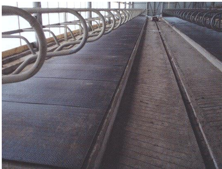
Рис. 37. Секция с боксами для отдыха коров при беспривязном содержании, напольное покрытие – прорезиненные коврики
