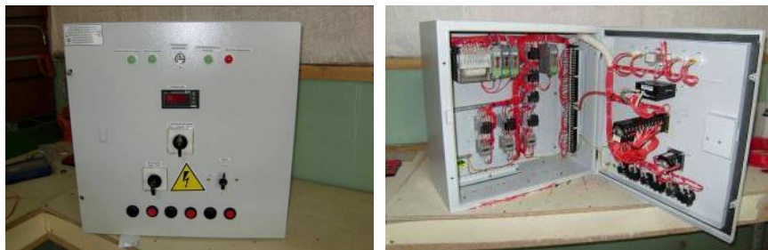
Рис. 18. Щит для управления и контроля приточной вентиляцией
