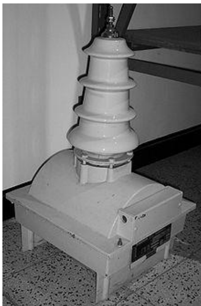
Рис. 11.4. Трансформатор напряжения
