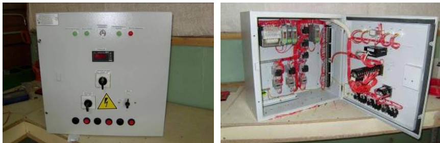
Рис. 18. Щит для управления и контроля приточной вентиляцией
