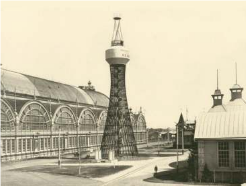
Гиперboloидная башня. Инженер В. Г. Шухов
