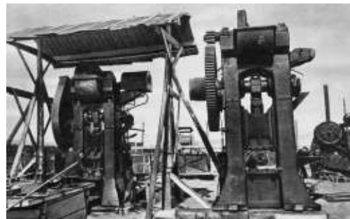
Монтаж оборудования на эвакуированном заводе. Казахстан. 1942 г.
