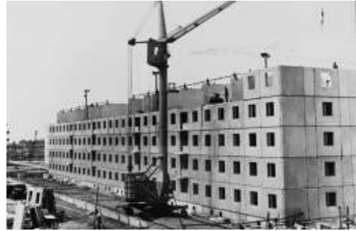
Строительство пятиэтажного жилого дома. Город Волжский
