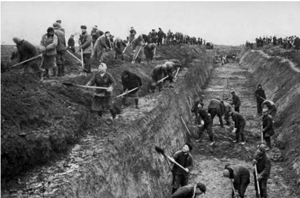
Строительство оборонительных сооружений под Москвой. Осень 1941 г.
