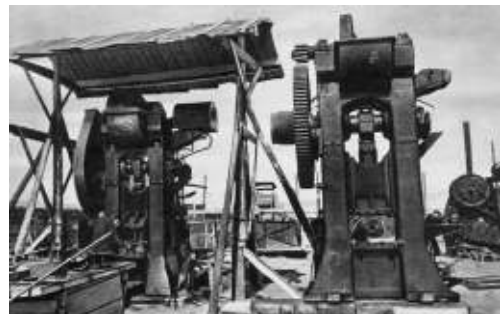
Монтаж оборудования на эвакуированном заводе. Казахстан. 1942 г.
