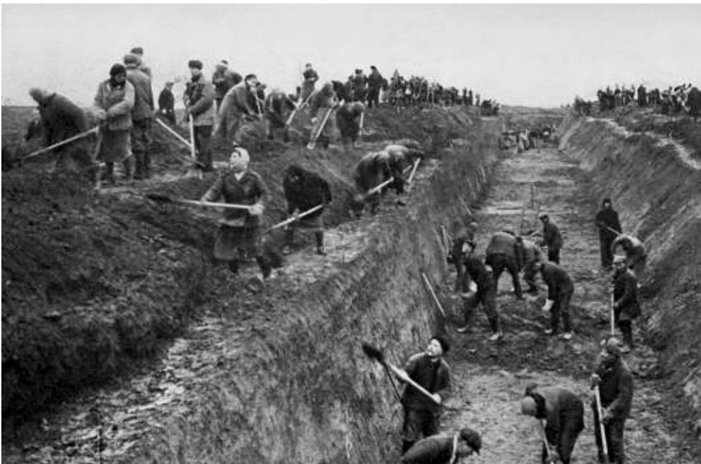
Строительство оборонительных сооружений под Москвой. Осень 1941 г.
