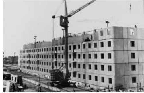
Строительство пятиэтажного жилого дома. Город Волжский
