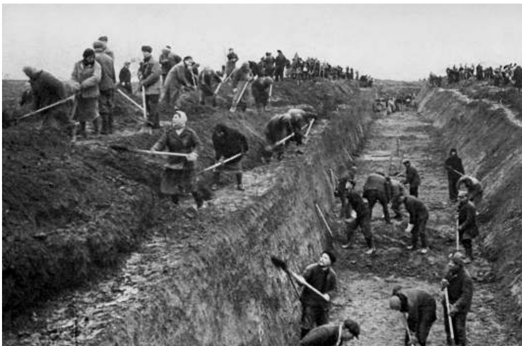
Строительство оборонительных сооружений под Москвой. Осень 1941 г.
