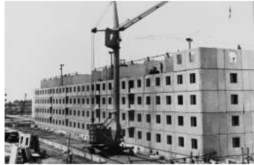
Строительство пятиэтажного жилого дома. Город Волжский
