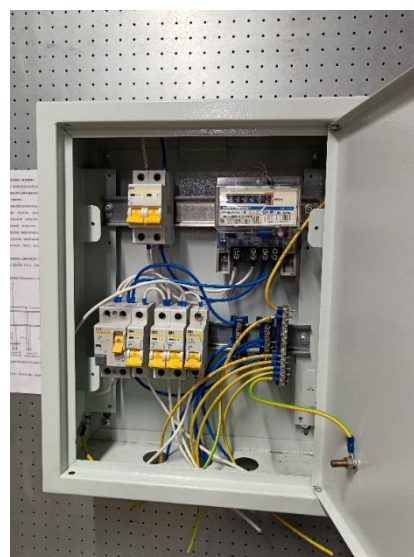
Рис. 2. Сборка вводно-распределительного щитка
