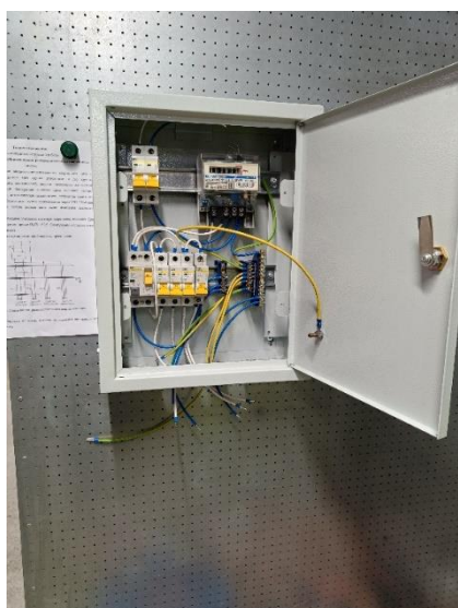
Рис. 2. Сборка вводно-распределительного щитка
