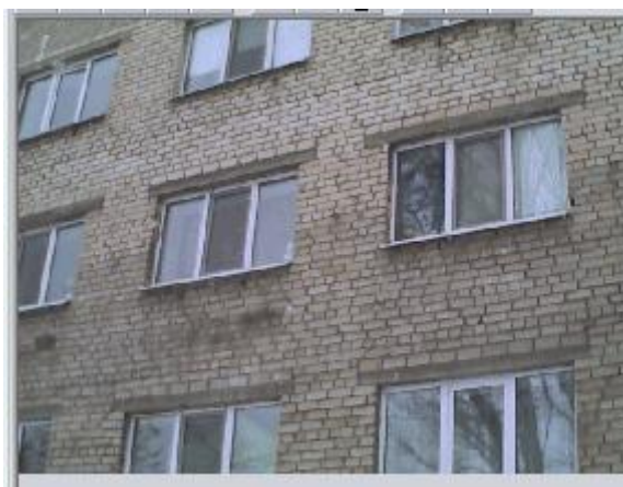
Рис. 2. Общий вид объекта
