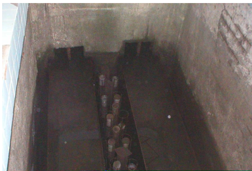
Рис. 3. План установки аэраторов в коридоре для биологической очистки
