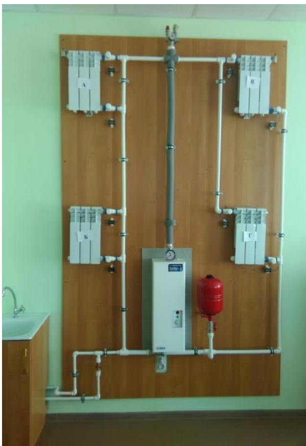
Рис. 3. Общий вид лабораторного стенда «Исследование систем отопления с естественной циркуляцией»
