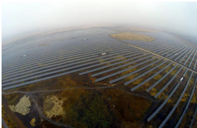
Рис. 1. Солнечная электростанция под Новокуйбышевском
