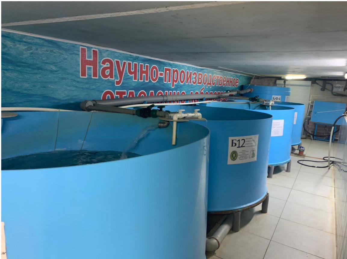
Рисунок 1 – Установки замкнутого водообеспечения для содержания осетровых рыб в условиях ПНИЛ «Разведение ценных пород осетровых»
